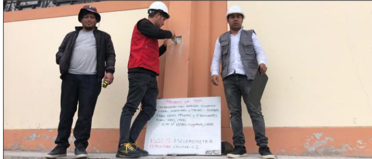
Figura 5. Realización del ensayo de esclerometría en los módulos de la institución educativa N° 10386
