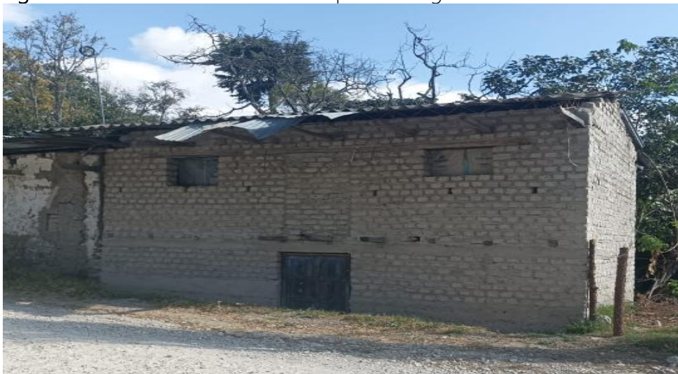
Figura 3. Edificación de albañilería no confinada típica del lugar de estudio.
